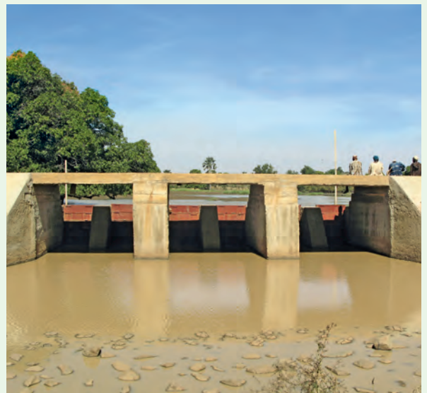
Petit barrage construit au Mali avec le soutien de la coopération allemande
